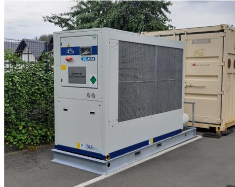
**WRK 93L-1-E-P3T- Kaltwassersatz mit 93 kW**
